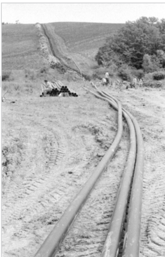
27. ábra: PE vezetéképítés az 1990-es években, tompahegesztett kötésekkkel
