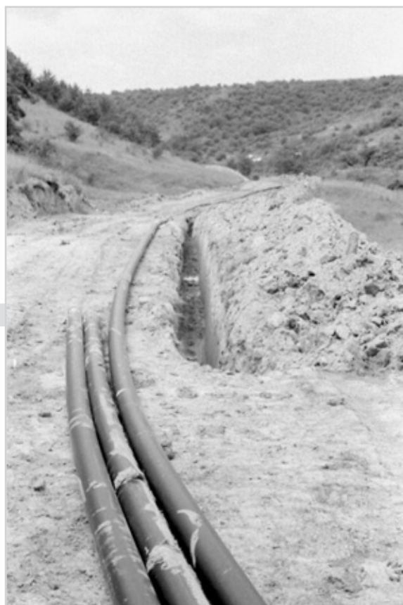
27. ábra: PE vezetéképítés az 1990-es években, tompahegesztett kötésekkkel
