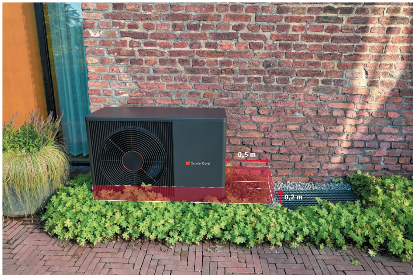
Telepítési példa a homlokzat elé állított kültéri egységre, környezetében üvegajtóval és szellőzőráccsal
